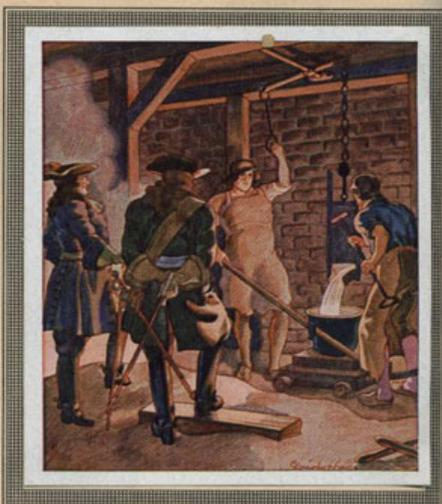
BILD 98: EISENGIESSEREI. In der Gewinnung und Verarbeitung des Eisens hat Deutschland stets an hervorragender Stelle gestanden. „Hohe Ofen“ waren bereits im Mittelalter in Betrieb. Während man damals das Eisen noch unmittelbar aus dem Hochofen in Behälter goß, fing man gegen Ende des 17. Jahrh. an, den eigentlichen Eisenguß und die reine Eisengewinnung im Hochofenprozeß voneinander zu trennen.
